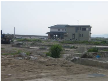
いわき市 津波被害
